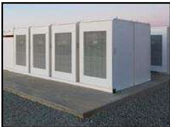
Imagen 20. Contenedores baterías sobre losa de hormigón
